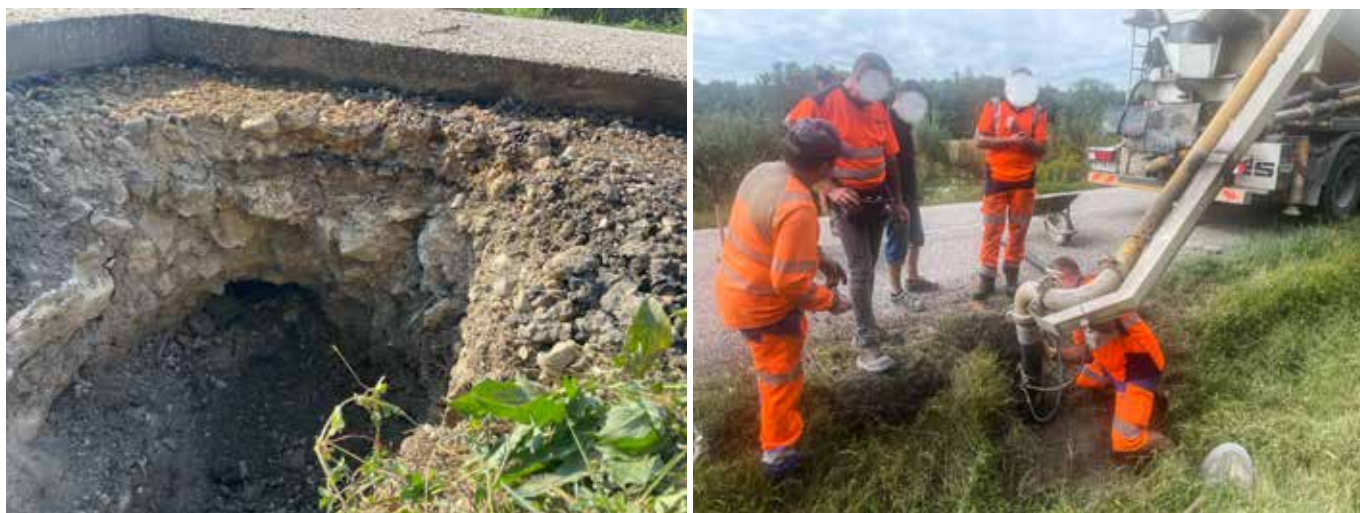
Les gueules actives sont dégagées, puis du béton y est injecté
