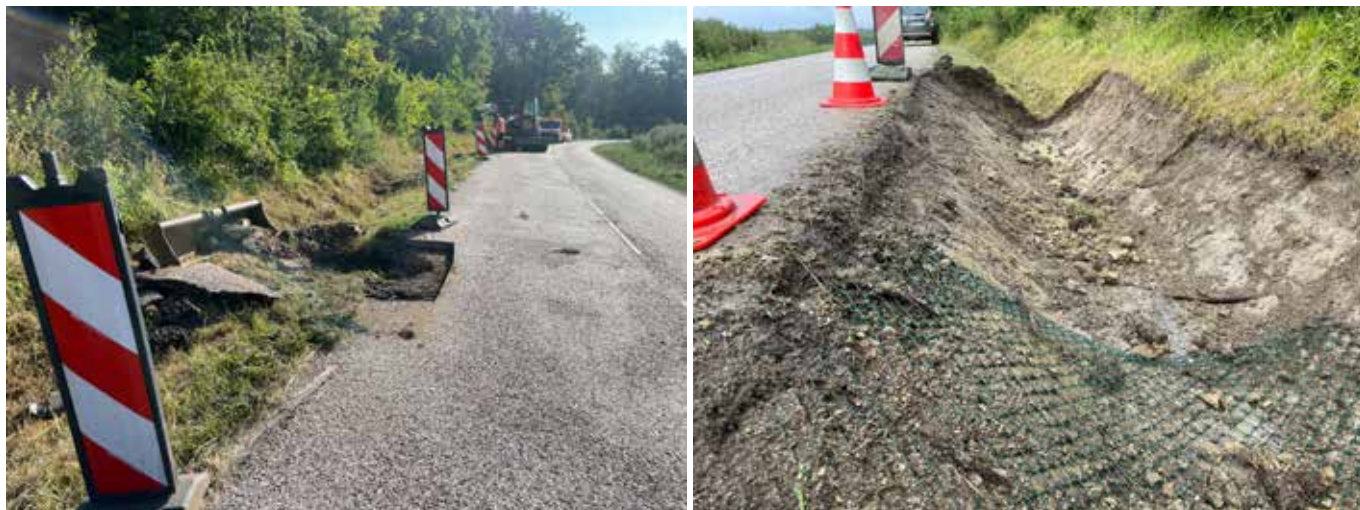
Le 11 juillet 2023, la petite famille a décampé, les travaux débutent : Le fossé est décapé, un grillage épais est solidement fixé, puis recouvert de terre.
